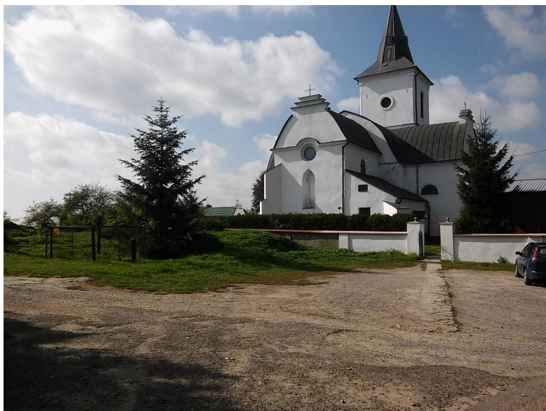
Łoniów, Kościół Parafialny i jego otoczenie – potrzeba renowacji oraz zagospodarowania otoczenia ciągi komunikacyjne, (fot. P. Pietruszka – FRESH-BIZ)
