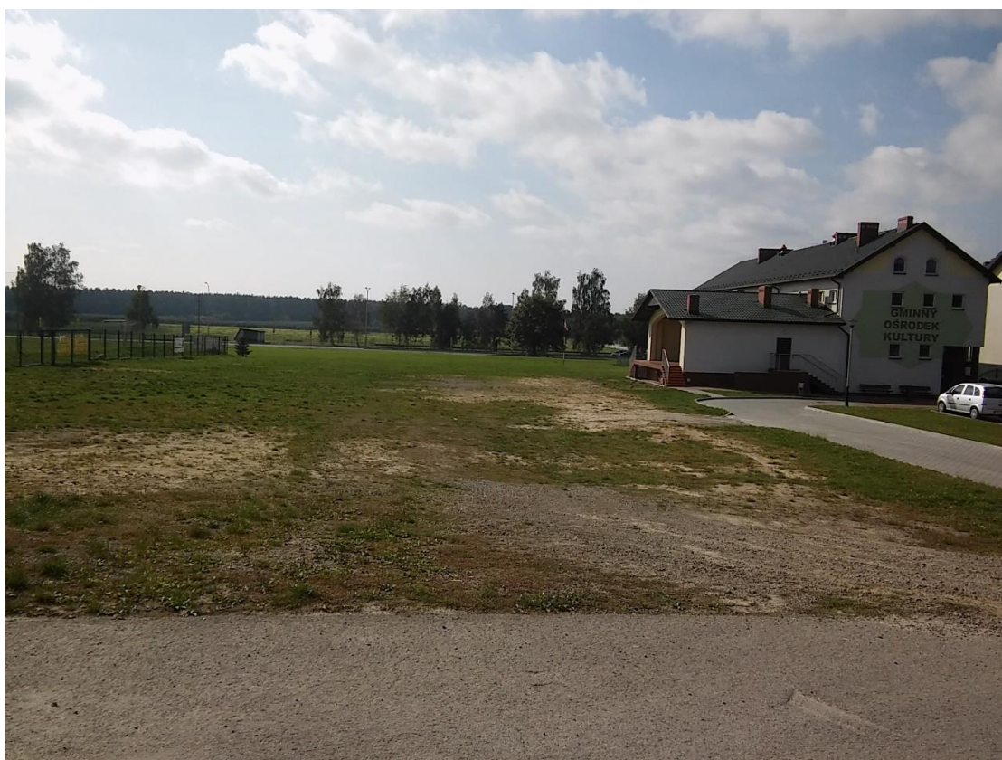
Łoniów, otoczenie budynku Urzędu Gminy i Gminnego Ośrodka Kultury – potrzeba lepszego zagospodarowania otoczenia (fot. P. Pietruszka – FRESH-BIZ)
