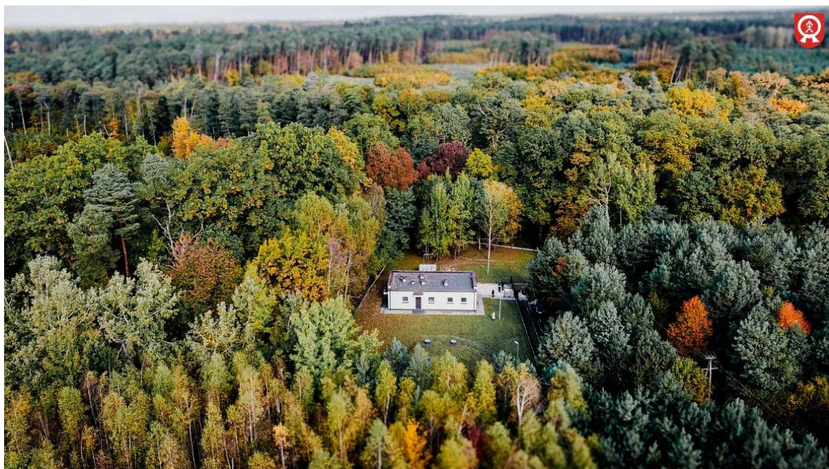
Modernizacja sieci wodociągowej
