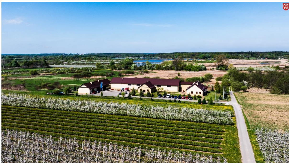
Modernizacja oczyszczalni ścieków
